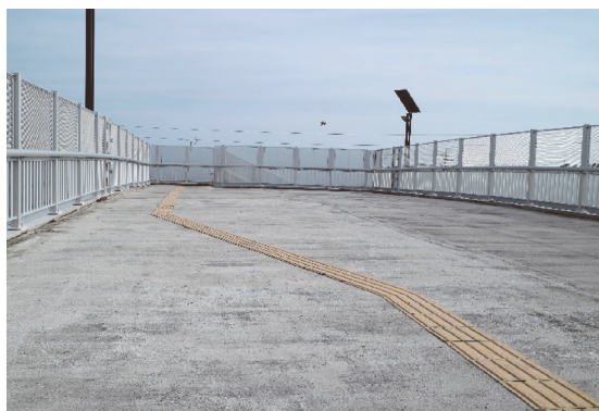
津波避難タワー B の避難場所
