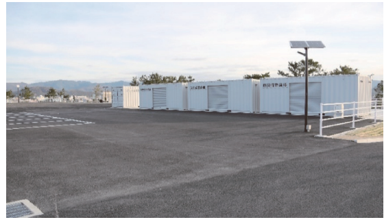
コンテナ倉庫
