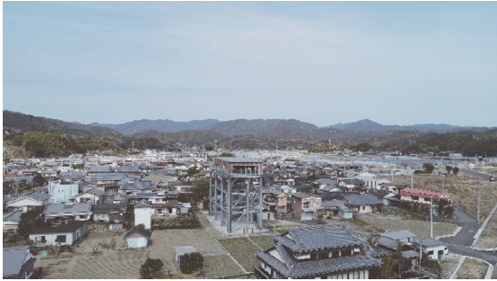
早咲地区津波避難タワー
