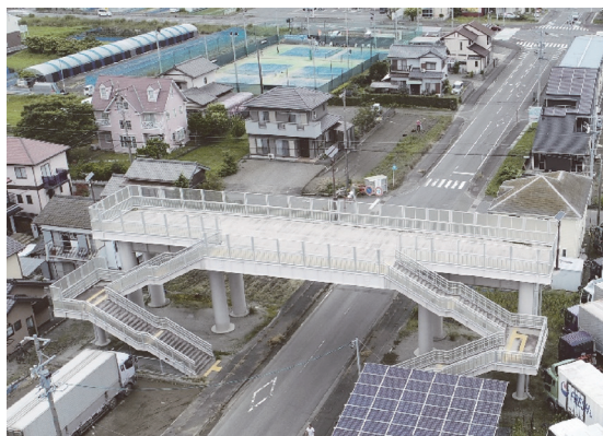
横断歩道橋型の津波避難タワー A
