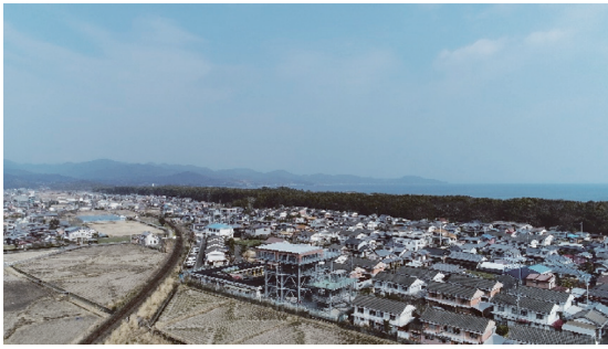
万行地区津波避難タワー
