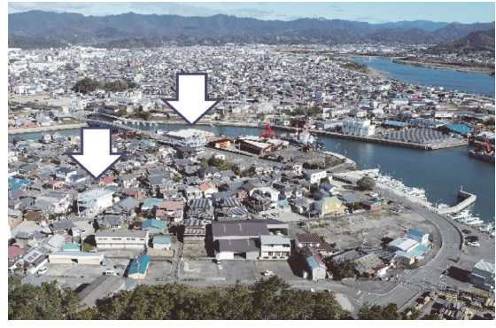
延命タワーと浜ノ瀬地区津波避難タワー
