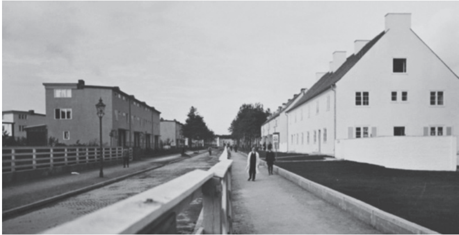
図3 フィッシュタール・ジードルンク外観写真(1927)
