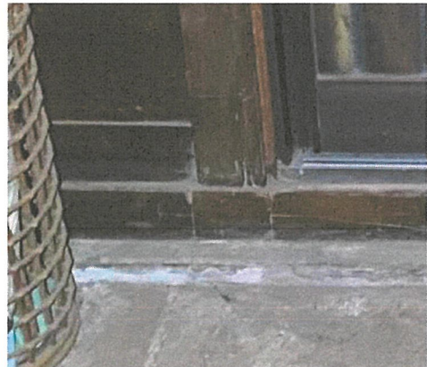
図 7-18 玄関開口部脇にみられた切断箇所
