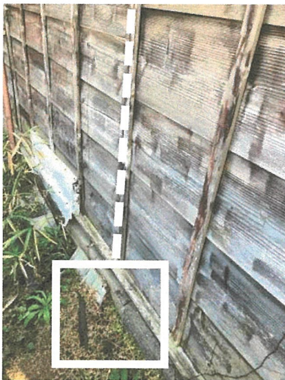
図 7-23 収納部分の外壁
