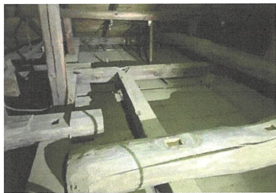
図 7-10 東側に多くみられた転用材の一例
