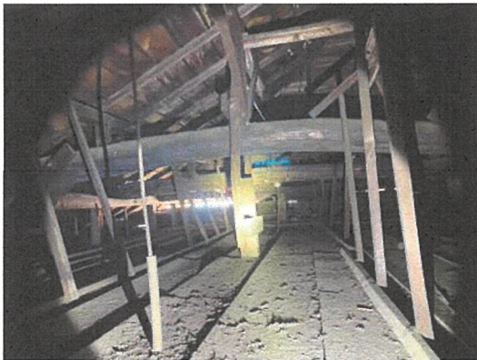
図 7-9 西側にみられる吊り天井
