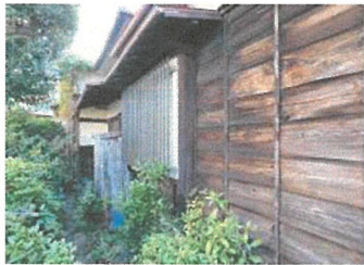
図 7-2 E 邸：下見板張りの外壁
