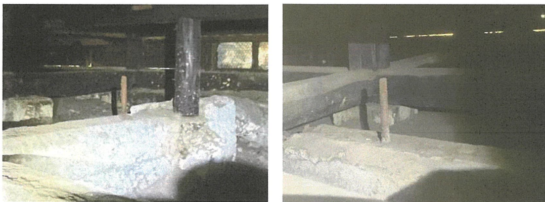
図 7-11 床下で確認された、使用されていないアンカーボルト
