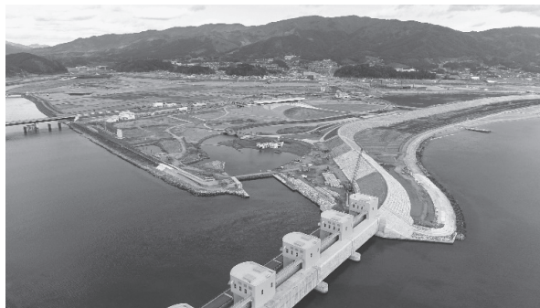
防潮堤と気仙川水門
