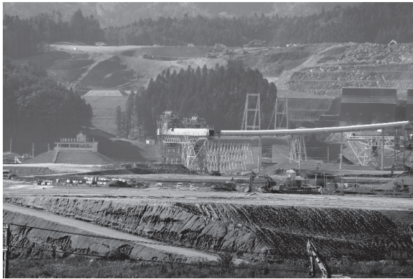
山から土砂を運搬するベルトコンベヤー（2014年）
