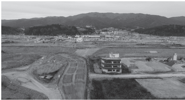
14.5 mの高さに嵩上げ工事中の高田地区（2017年）
