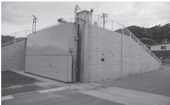
完成した開閉式の水門
