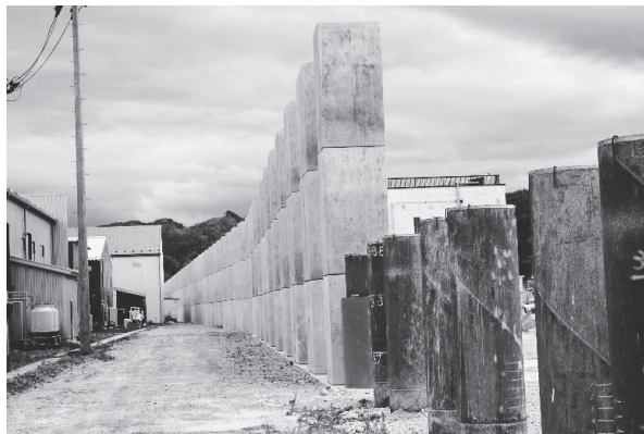
山田町で建設中の新防潮堤と基礎工事（2016年4月）
