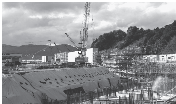
陸前高田市の防潮堤の基礎工事（2018年）
