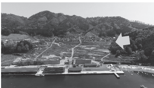
船越漁港と完成した土盛り堤防（2019年5月）
