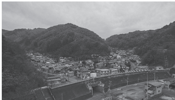
太田名部防潮堤（高さ 15.5 m、長さ 260 m）（2018 年）
