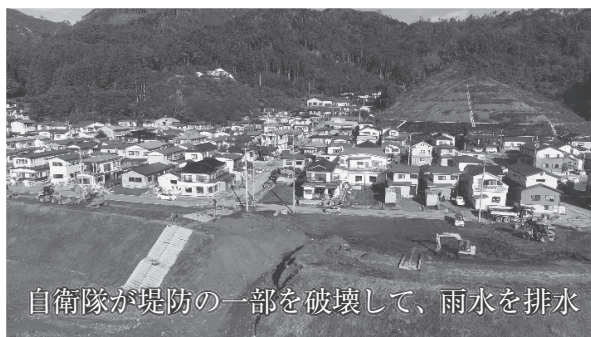
東日本台風による冠水被害の跡（2019年10月）
