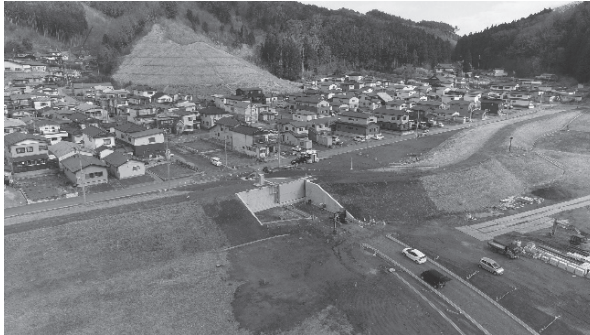
完成した開閉式の水門（2022年3月）
