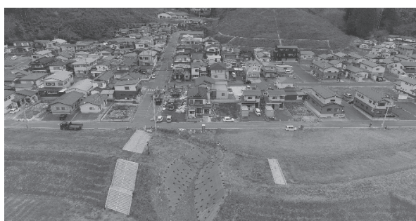
堤防の開口部と住宅の解体（2020年10月）
