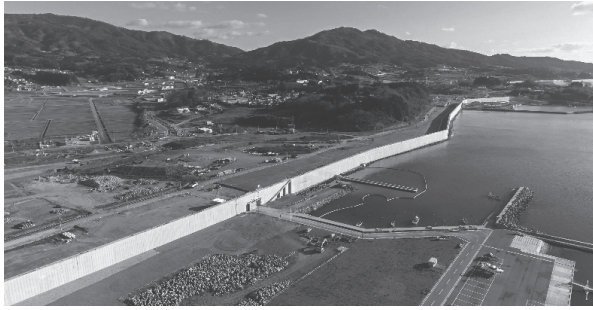
建設工事が進む防潮堤
