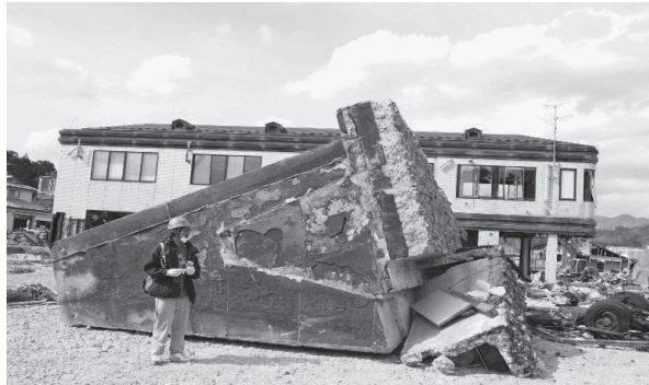
山田町の基礎工事のない防潮堤（2011年4月）
