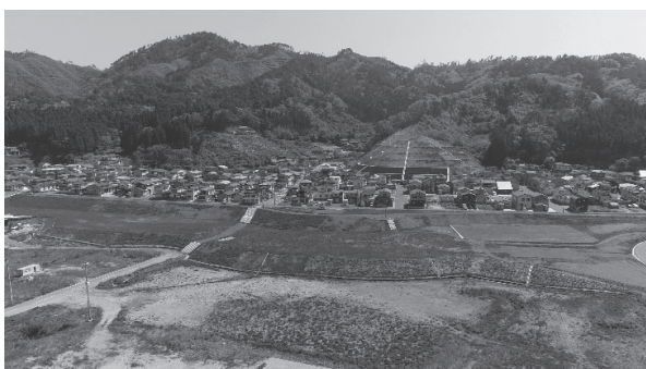
完成した高さ6.5mの土盛り堤防（2019年5月）
