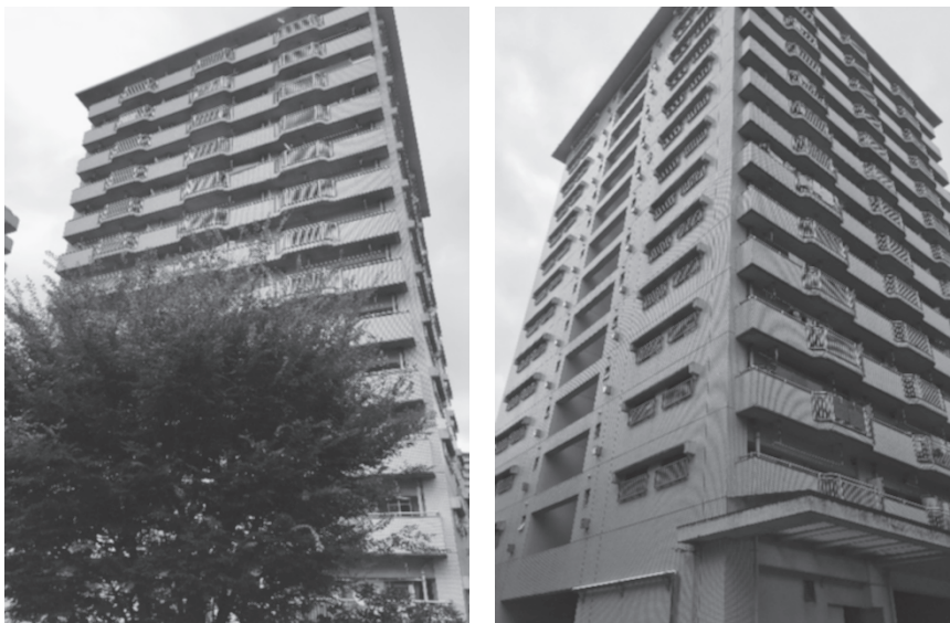
図1 対象棟の外観（左：西側・右：南東側）
