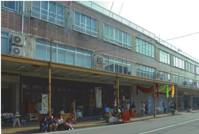
図7 魚津中央通り名店街の防火建築帯 外観(部分)
