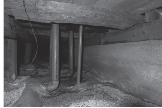
図6. 改修前の西棟床下
