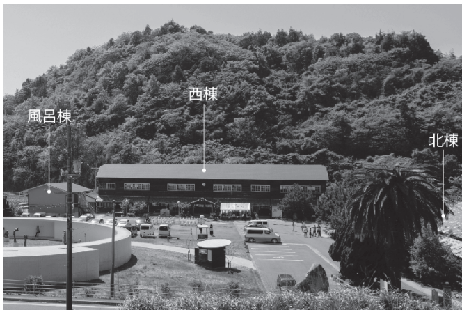
図7. 改修後の全景(正面が西棟, 右手が北棟, 左手が風呂棟)
