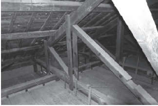
図5. 改修前の西棟屋根裏
