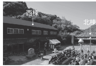
図8. 改修後の西棟, 北棟
