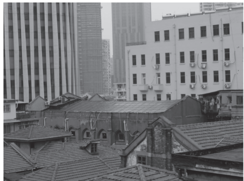
写真 22 老靶子路の建物・側面
