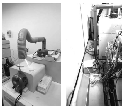
図7 フレキシブル局所排気システム(左)と背面部分に送風機箱(右)
