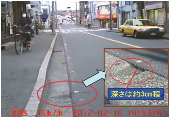
図7 リンレコで判る道路面3cmの窪み(横浜市鶴見区)
