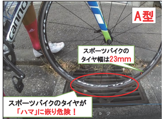
図8 排水溝蓋スリット(28mm)にスポーツ車タイヤ(23mm)が嵌る
