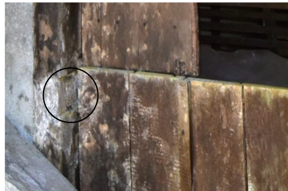
写真 3-7 窓台が崩壊した沖山剛造家住宅の窓枠（○印内）
