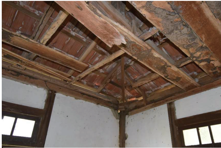
写真 3-1 雨漏りにより劣化が進む深澤家住宅
