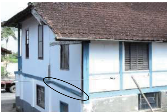
写真3-2 外に向かって傾斜する下屋の床(○印内)
