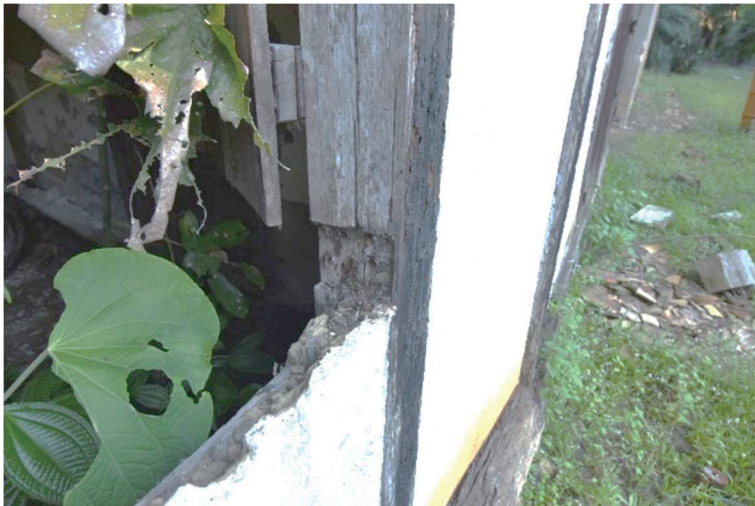
写真 3-5 窓台が崩壊した深沢家住宅の窓枠
