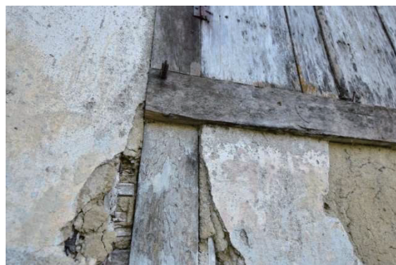
写真 3-9 土壁が崩壊した清水家住宅兼製茶工場の窓枠
