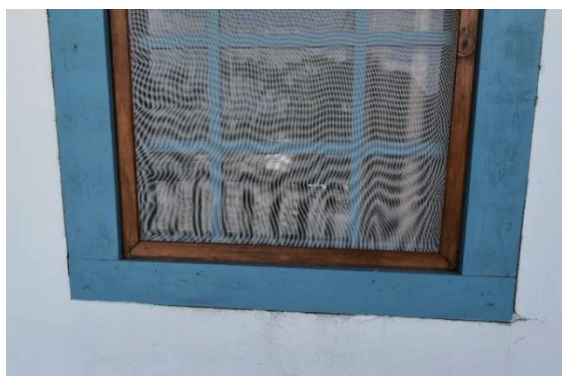
写真 3-8 天谷家住宅の大壁造りの「合じゃくり」窓枠
