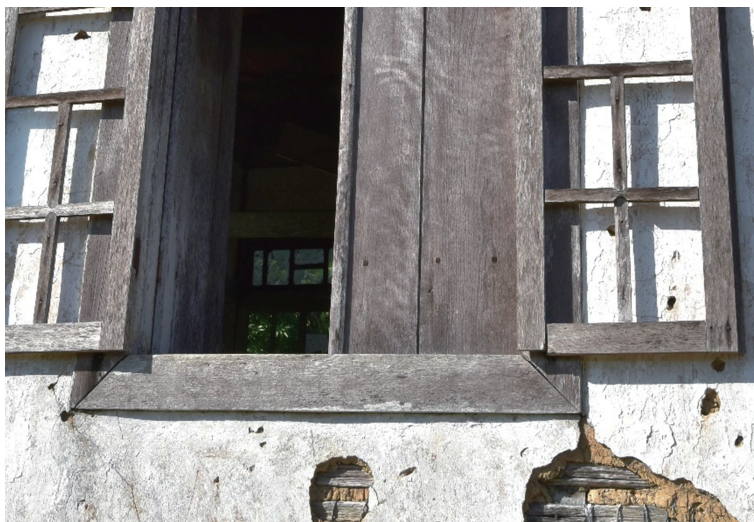
写真 3-10 六川家住宅の大壁造りの「大留め」窓枠
