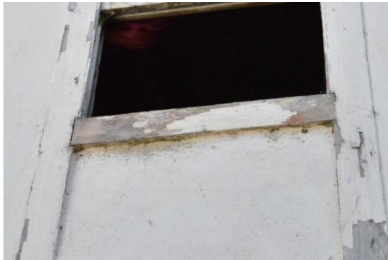
写真 3-6 沖山スズ家住宅の真壁造りの窓枠
