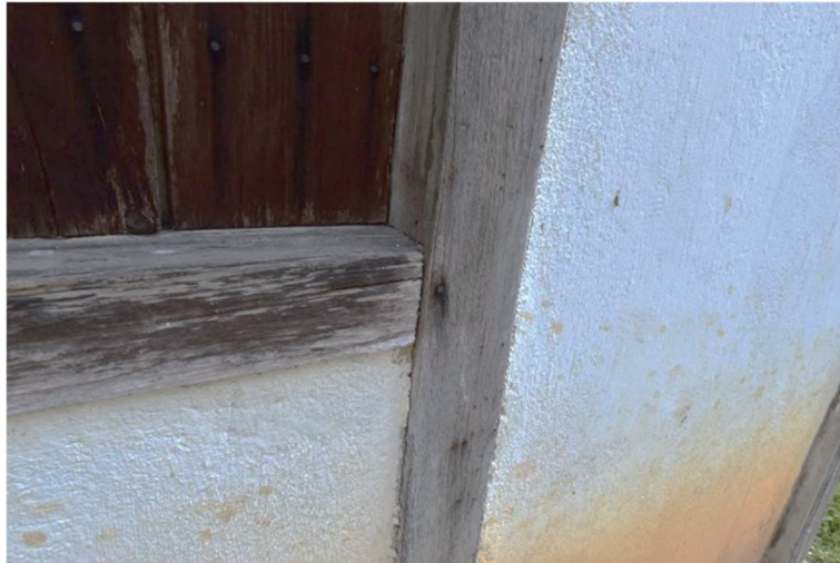
写真 3-4 深沢家住宅の真壁造りの窓枠
