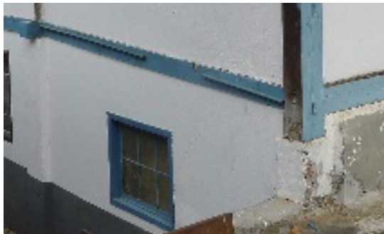
図 2-5-5 下屋コーナー部の柱脚
