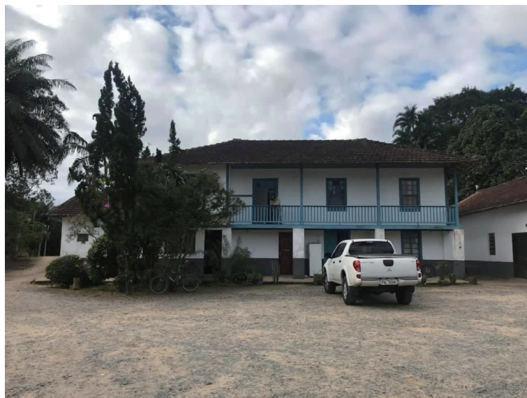
図 2-5-1 天谷家住宅 北側外観
