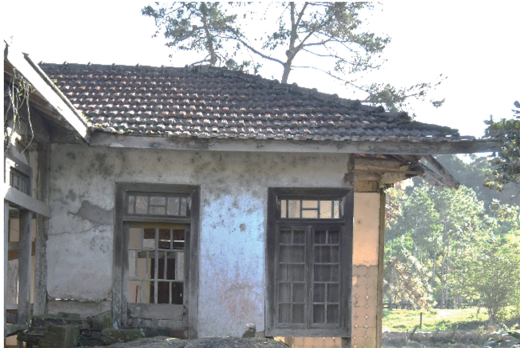
写真 2-4-7 残された屋根より確認できる軒反り
