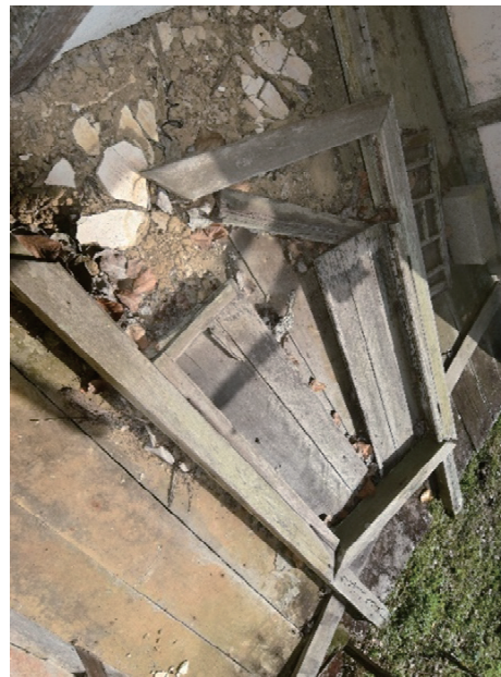
写真 2-4-6 崩壊した窓枠
