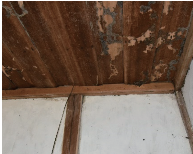
写真 2-1-5 「住居」2 階の天井仕上げ
