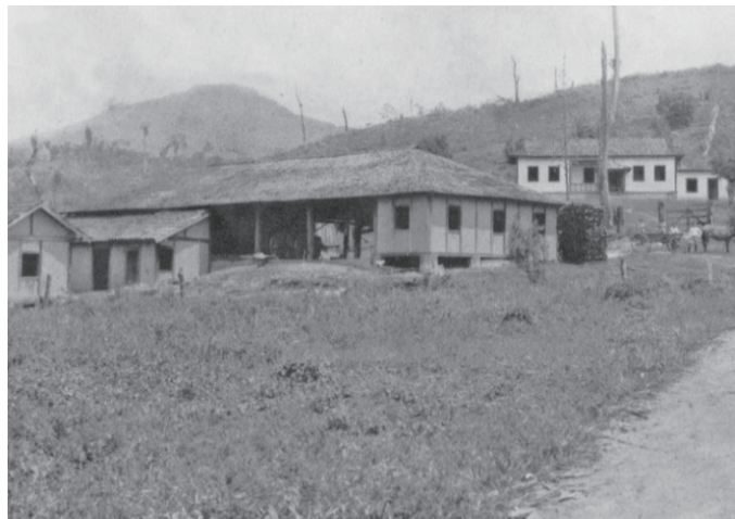
図2-1-2 『イグアッペ写真帖』に掲載されている池上熊太郎家住宅兼工場
