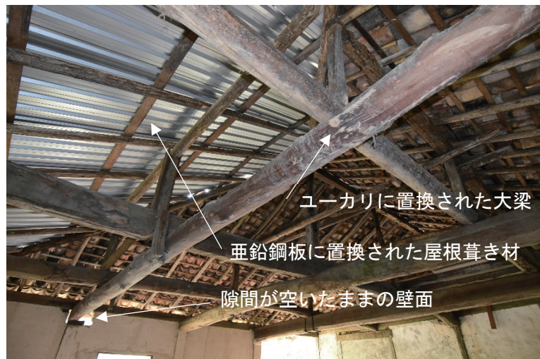
写真 2-1-3 「工場」の小屋組み
