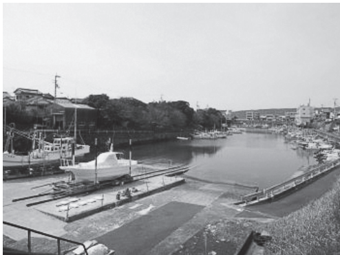
写真1 高知県室戸市浮津の風景 (撮影：加藤幸治)
