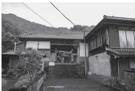
写真1 長浜の大川家長屋門
