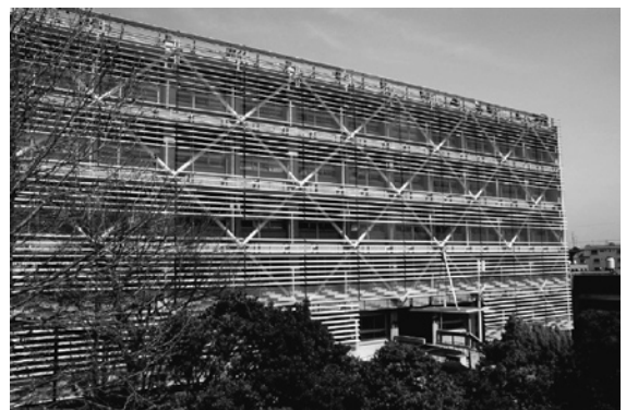
図31 東工大緑ヶ丘1号館耐震補強
