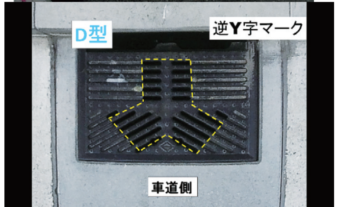
図2 道路側溝排水溝蓋のリスク：自転車のみ被害者 図3 排水溝蓋スリットにスポーツ自転車タイヤが嵌る 図4 改善された排水溝蓋：スポーツ自転車タイヤは嵌らない
