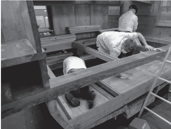
写真2 作業状況 (2019年6月15日)
