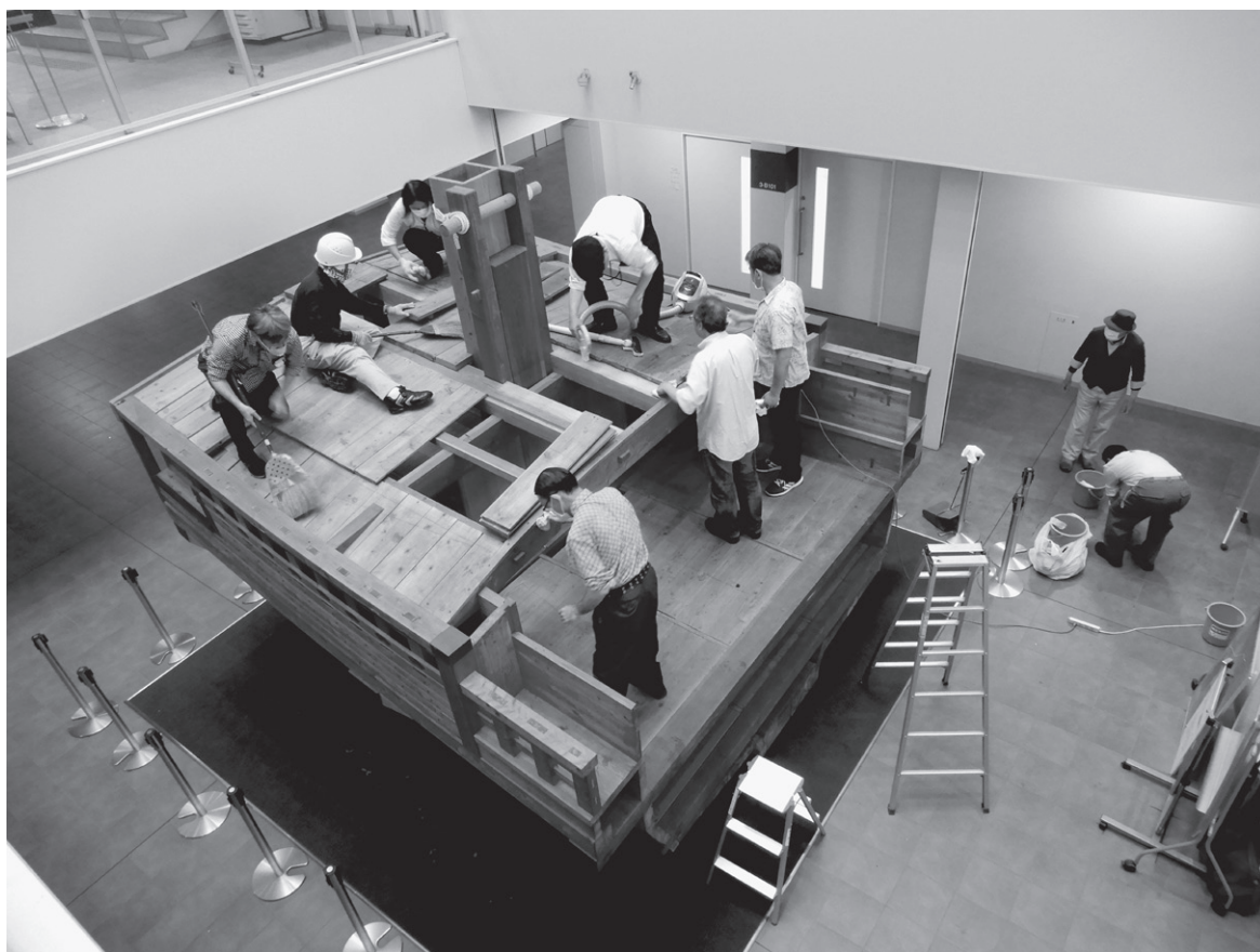
写真1 作業状況（2019年6月15日）
