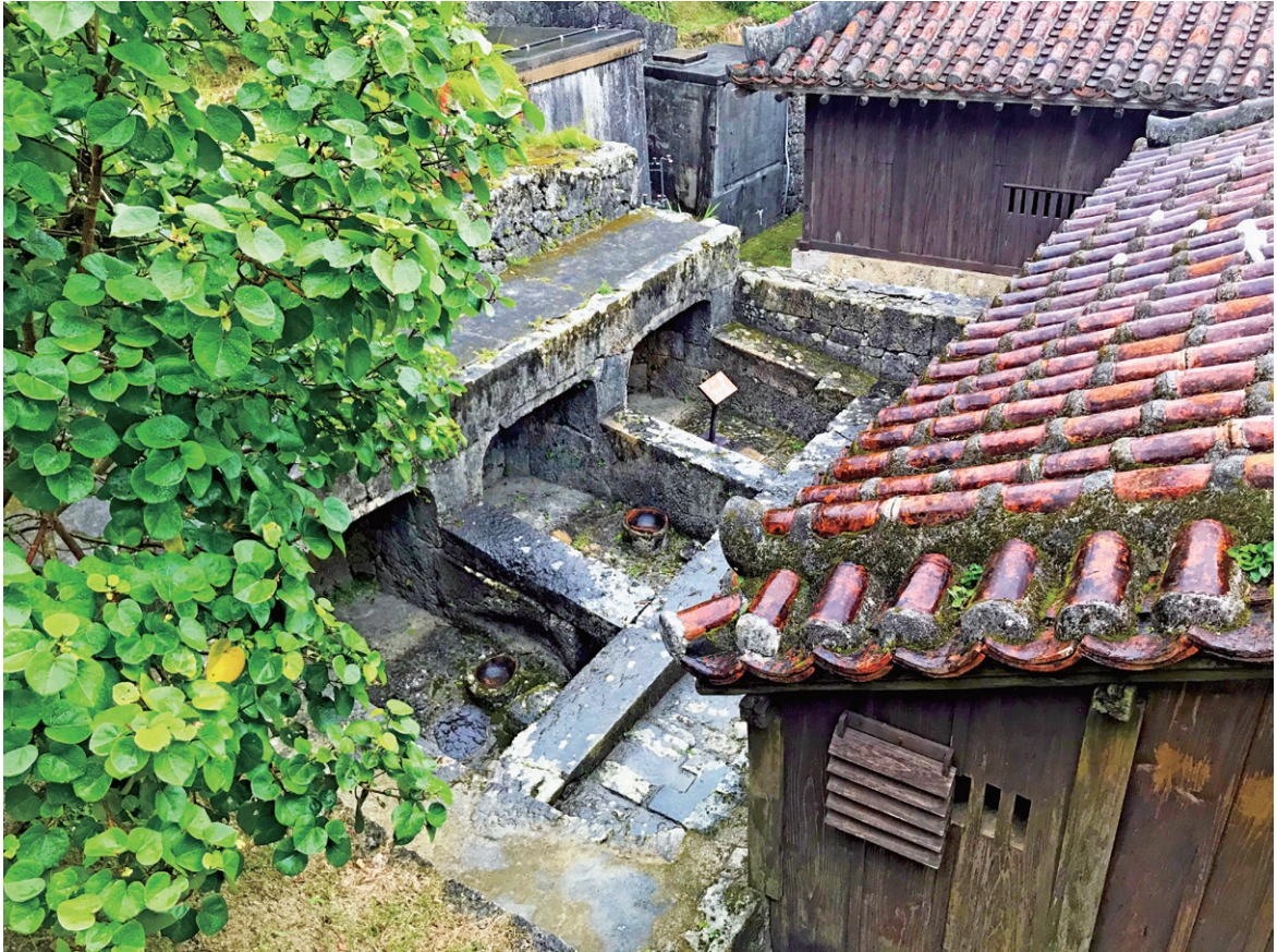
写真2 重要文化財中村家住宅(沖縄県中頭郡北中城村)フル(豚便所)全体像(須崎撮影/2019年12月)
