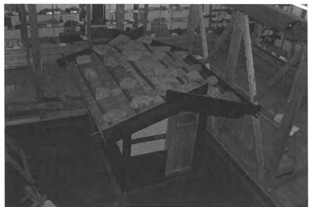
写真3 サンゴヤ上部 石置屋根
