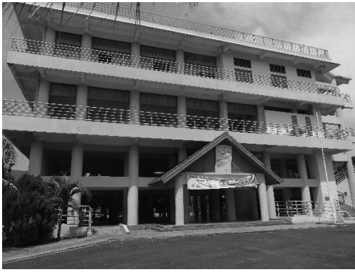
写真7 RC造の津波避難タワー
