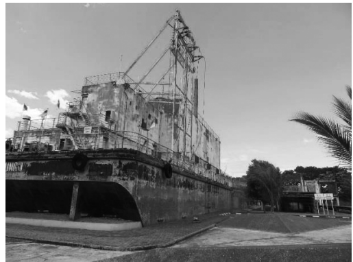
写真10 エンジンが被災地の電力供給施設となった漂流船（震災遺構）
