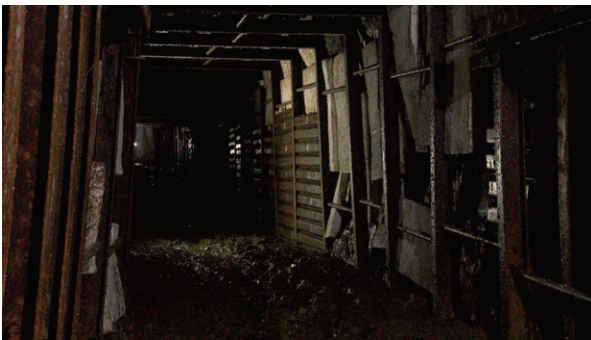
図3 補強が施されている第5坑道(2020年撮影。琉球新報社提供)
