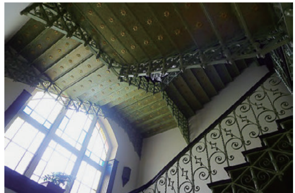
写真3 旧海浜旅館内部
