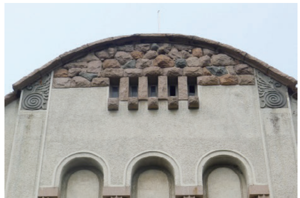
写真7 旧日本人青島中学校校舎正面の妻面
