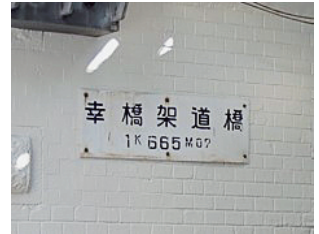
【図1】幸橋架道橋橋梁下の掲示板
