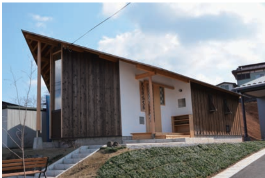
工学部建築学科重村・三笠研究室との協働で完成した大島漁協文庫
