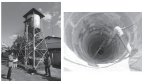
図19 左図：井戸外観 右図：井戸内部見下げ
