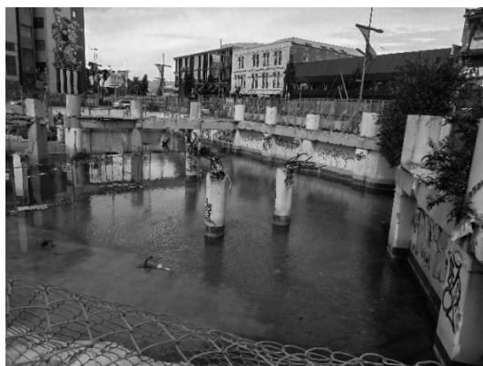
写真 14 被災した建物の遺構
