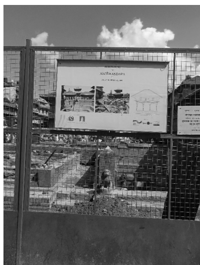
写真7 歴史的建造物の修復工事
