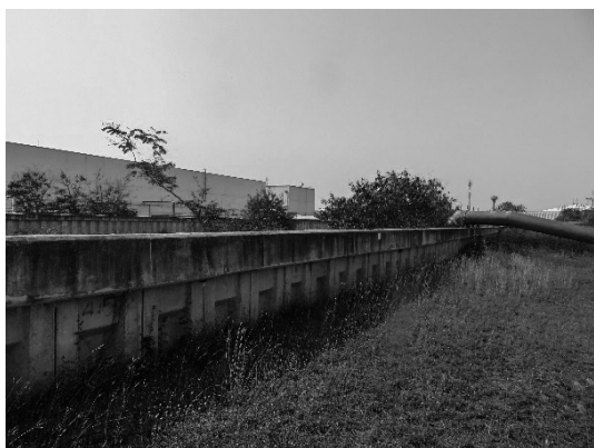
写真 25 工業団地の堤防と排水ポンプ
