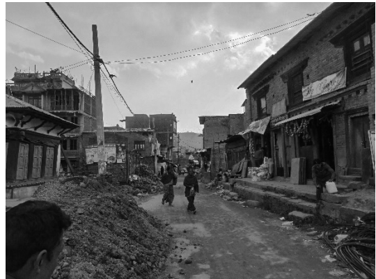
写真10 被害を受けた集落の状況
