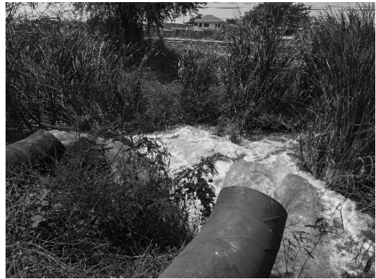
写真 28 排水ポンプによる排水状況
