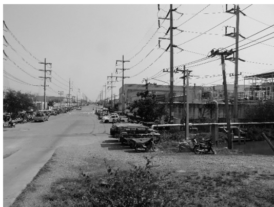
写真 26 広大な工業団地を囲む堤防
