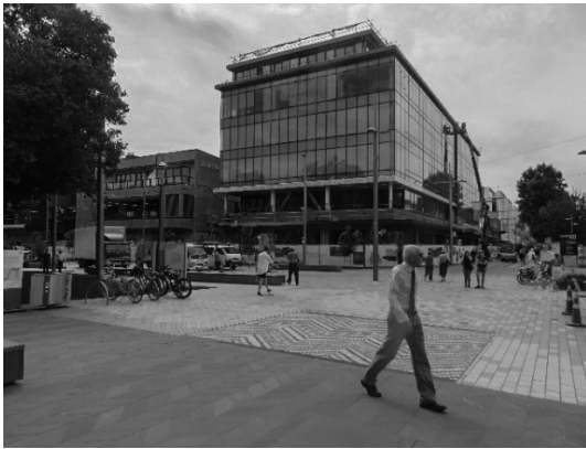
写真15 中心市街地“シティー”の復旧・復興状況
