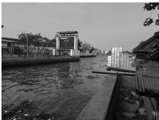
写真 31 チャオプラヤ川に設置された水門
