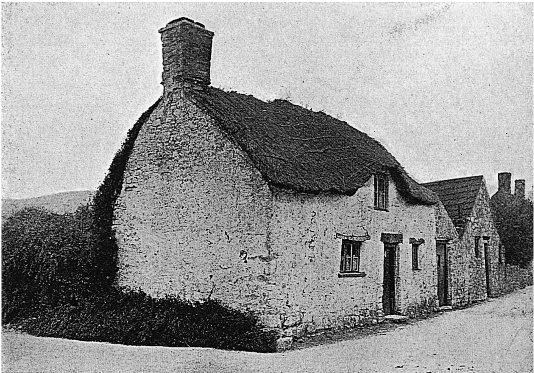
【図5】 典型的な農業労働者住宅の例（窓が小さく、通風が悪い。藁葺き屋根は煙突の下で破損している）
