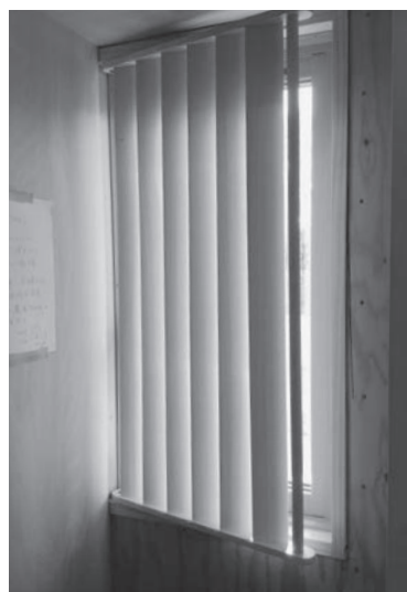
写真5 垂直ルーバーの設置
