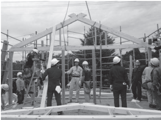
写真5 学生と専門家のコラボによる棟上げ
