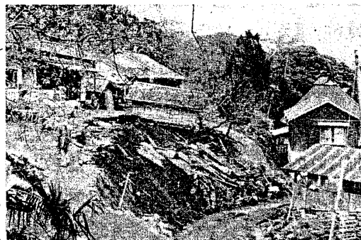
写真-8 内山部落 石垣擁壁崩壊
