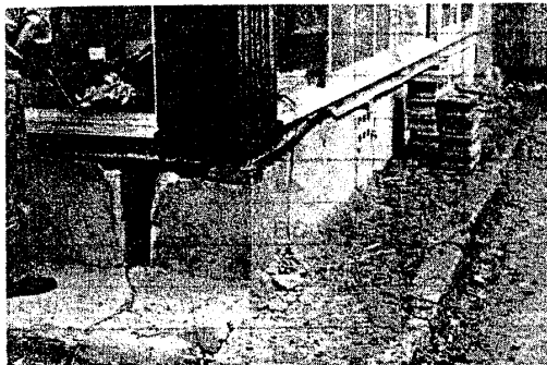
写真-7 秋吉氏宅(平原部落)の基礎破壊
